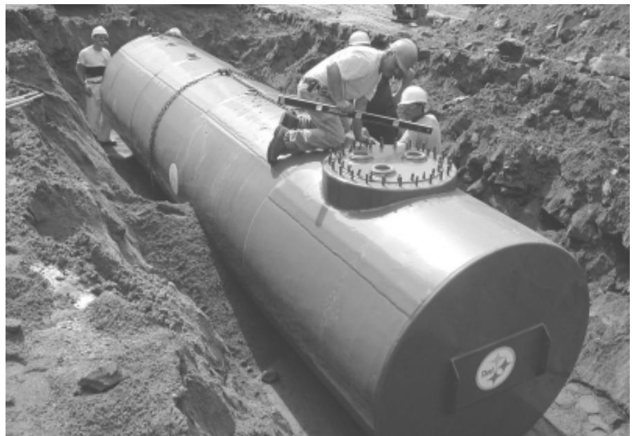
De oude brandstoftank dient uitgegraven te worden en een nieuwe geplaatst
